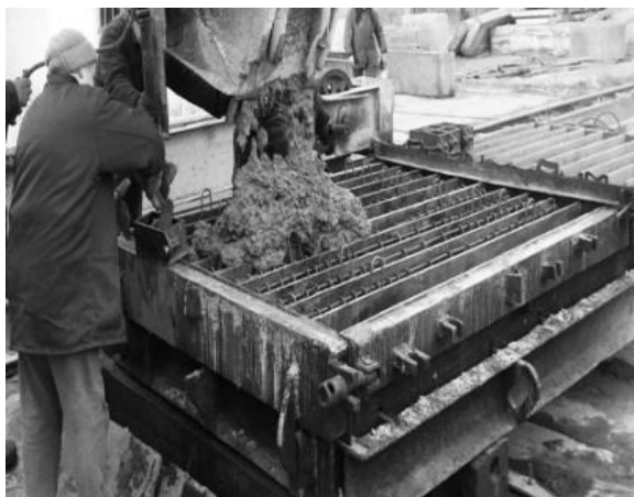
Рис. 2.4.1 Укладання суміші в опалубку з подальшим ущільненням на вібростолі
