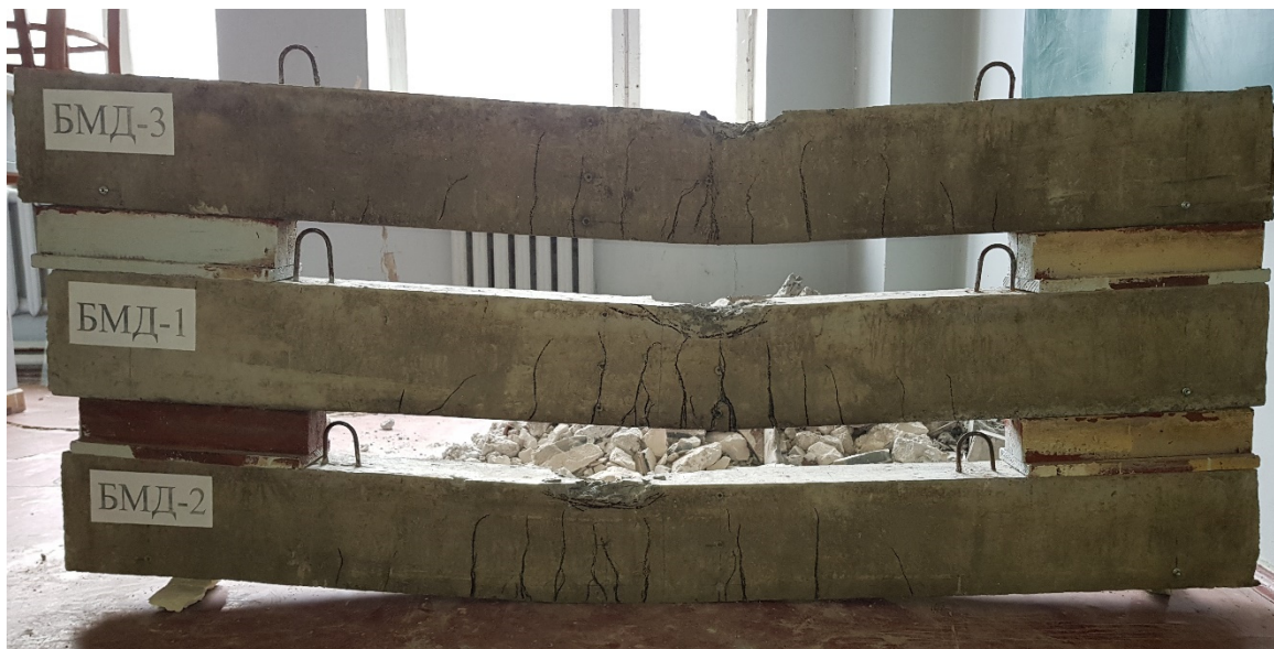
Рис. 3.2 Загальний вид балок серії БМД, зруйнованих за нормальними перерізами
